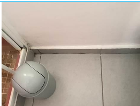
Matériaux : Z07 - Ensemble Bâtiment - Salle de bain, WC - Plinthe 45x10 - Colle de Plinthe Prélèvement : P019 Description : colle de plinthe Localisation : Bâtiment 009 - Logement 001 - Salle d'eau Résultat : Absence d'amiante
