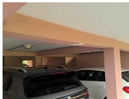
Matériaux : Z20 - Façades extérieures - Poutre - enduit + peinture Prélèvement : P002 Description : enduit + peinture Localisation : Bâtiment 009 - Hall - Poutre Résultat : Absence d'amiante
