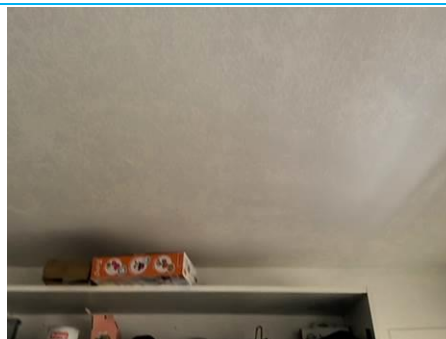
Matériaux : Z02 - Ensemble Bâtiment - Cuisine, Salle d'eau, WC - Plafond - Peinture + enduit Prélèvement : P022 Description : enduit + peinture Localisation : Bâtiment 009 - Logement 002 - Cuisine Résultat : Présence d'amiante
