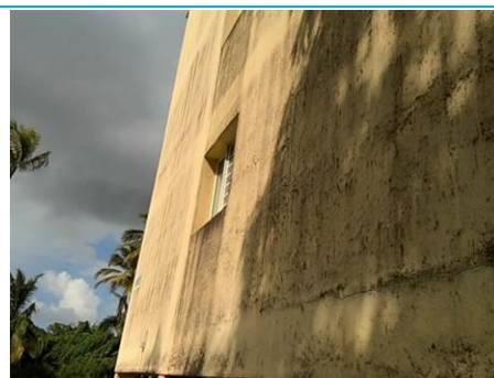
Matériaux : Z26 - Façades extérieures - Embrasement fenêtre - enduit + peinture Prélèvement : P006 Description : enduit + peinture Localisation : Bâtiment 009 - Façades extérieures - Nord - Embrasement Résultat : Absence d'amiante
