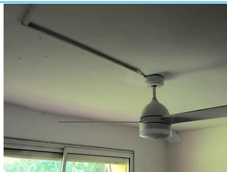
Matériaux : Z08 - Ensemble Bâtiment - Séjour, Dégagement, Chambres - Plafond - enduit + peinture Prélèvement : P028 Description : enduit + peinture Localisation : Bâtiment 009 - Logement 002 - Chambre 3 Résultat : Présence d'amiante
