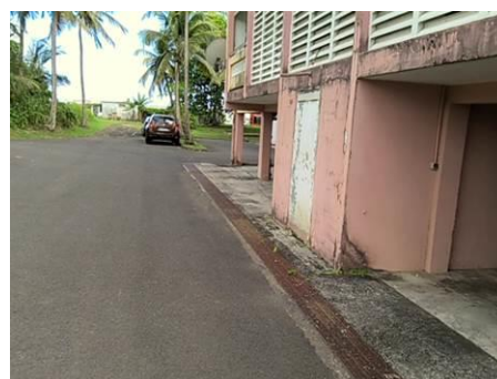
Matériaux : Z18 - Façades extérieures - Mur - enduit + peinture Prélèvement : P004 Description : enduit + peinture Localisation : Bâtiment 009 - Façades extérieures - Sud Résultat : Absence d'amiante
