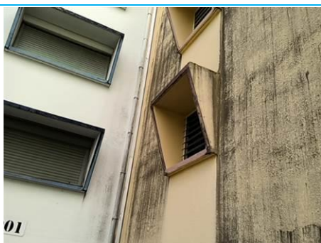
Matériaux : Z18 - Façades extérieures - Mur - enduit + peinture Prélèvement : P003 Description : enduit + peinture Localisation : Bâtiment 009 - Façades extérieures - Est - Mur Résultat : Absence d'amiante
