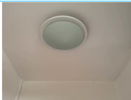
Matériaux : Z08 - Ensemble Bâtiment - Séjour, Dégagement, Chambres - Plafond - enduit + peinture Prélèvement : P032 Description : enduit + peinture Localisation : Bâtiment 009 - Logement 003 - Dégagement Résultat : Présence d'amiante
