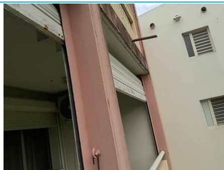
Matériaux : Z25 - Façades extérieures - tranche verticale - enduit + peinture Prélèvement : P040 Description : enduit + peinture Localisation : Bâtiment 009 - Façades extérieures Ouest - Arrière tranche verticale Résultat : Absence d'amiante
