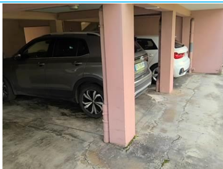
Matériaux : Z19 - Façades extérieures - Poteau - enduit + peinture Prélèvement : P001 Description : enduit + peinture Localisation : Bâtiment 009 - Hall - Poteau Résultat : Absence d'amiante
