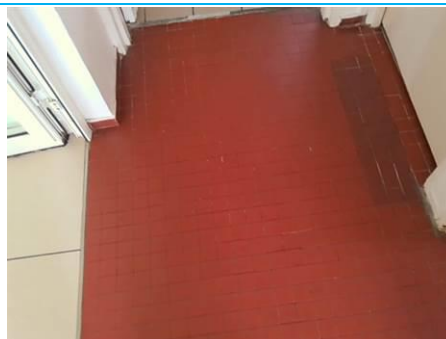
Matériaux : Z11 - Ensemble Bâtiment - Séjour, Dégagement, Chambres - Sol 5x5 - Colle de carreau Prélèvement : P034 Description : colle de carreau Localisation : Bâtiment 009 - Logement 003 - Dégagement Résultat : Absence d'amiante
