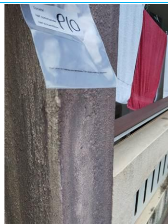
Matériaux : Z25 - Façades extérieures - tranche verticale - enduit + peinture Prélèvement : P010 Description : enduit + peinture Localisation : Bâtiment 009 - Façades extérieures Est - Tranche vertical Résultat : Absence d'amiante
