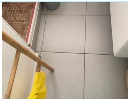
Matériaux : Z06 - Ensemble Bâtiment - Salle de bain, WC - Sol 45x45 - Colle de carreau Prélèvement : P020 Description : colle de carreau Localisation : Bâtiment 009 - Logement 001 - Salle d'eau Résultat : Absence d'amiante
