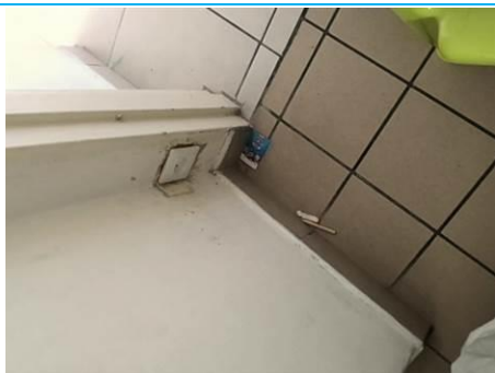
Matériaux : Z21 - Ensemble Bâtiment - Séjour, Dégagement - Plinthe 20x10 - Colle de plinthe Prélèvement : P029 Description : colle de plinthe Localisation : Bâtiment 009 - Logement 002 - Chambre 3 Résultat : Absence d'amiante
